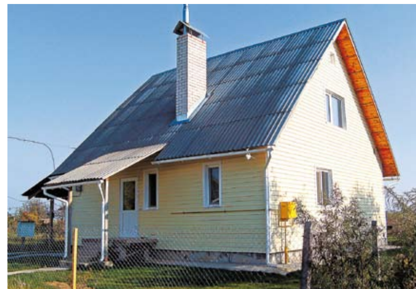
Етапи зведення будинку в с.Гатному: від каркаса до готової споруди
